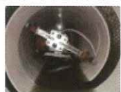
樹脂製の新しい内壁を形成
