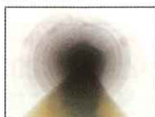
工事完成後の下水道管の内部
